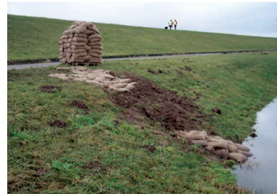
Elbhochwasser Januar 2011: Notverbau eines Bisamschadens im Außendeich-Bereich
