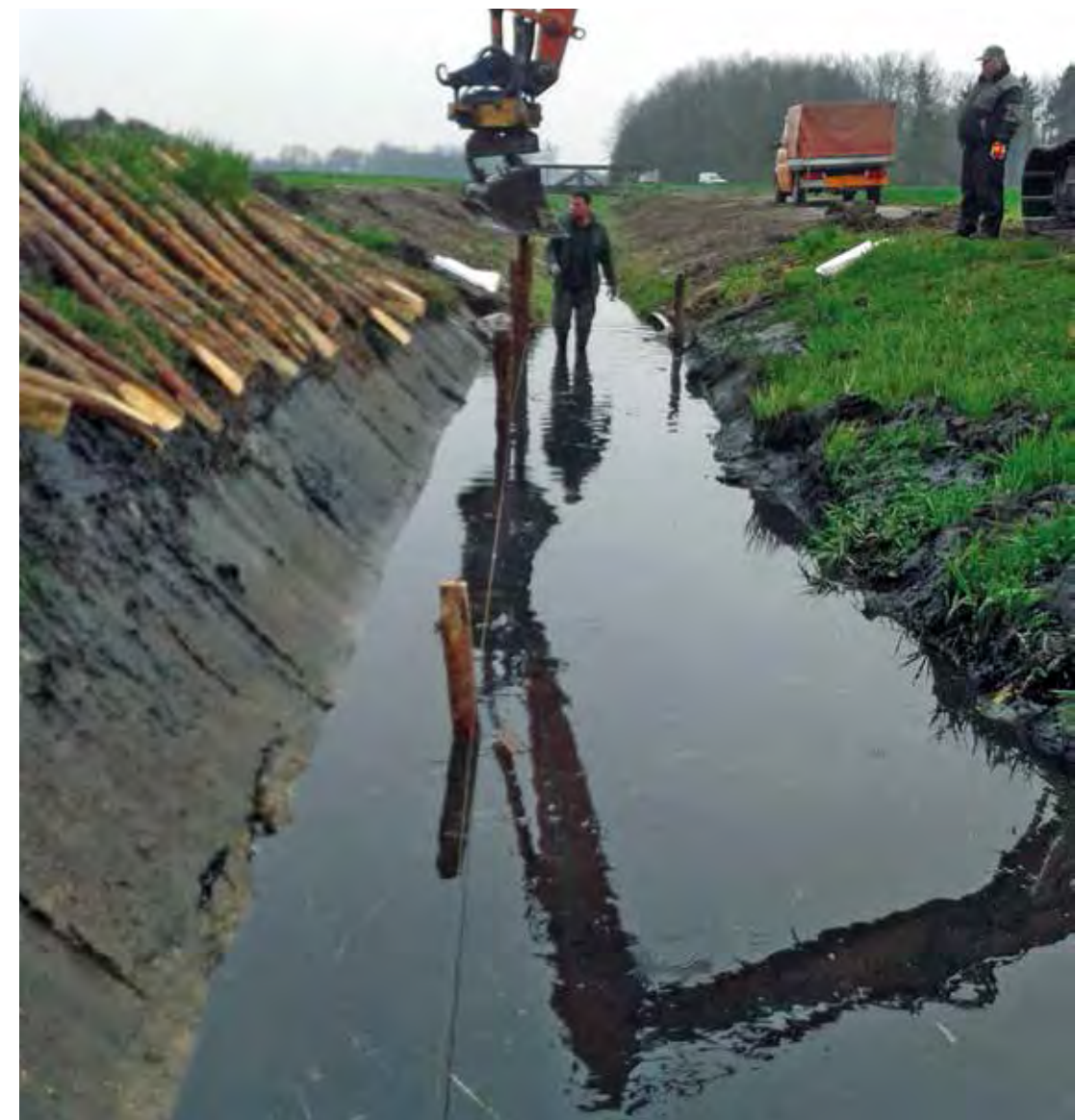
▲ Grundsanierung Ufer nach Nutriabefall Foto: Godehard Hennies
